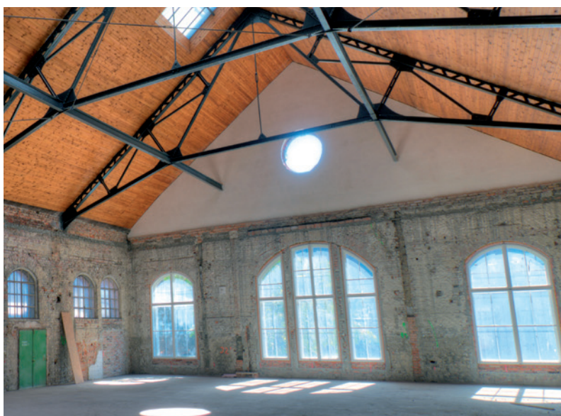
Vnútorné zateplenie doskami Multipor v areáli Hlubina v Dolných Vítkoviciach, Ostrava
